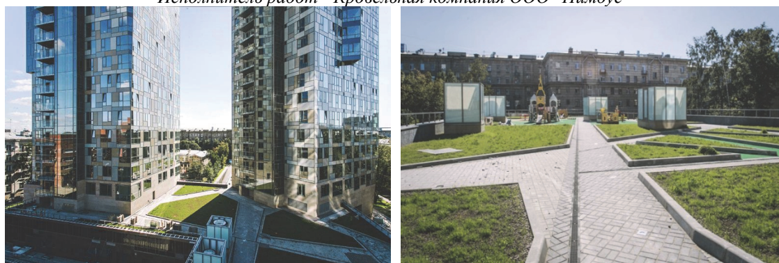
Жилой комплекс «КОСМОС» 2012 г. Интенсивное озеленение кровли выполнено по технологии Bauder. Исполнитель работ – компания «Строй Эксперт Витус»
