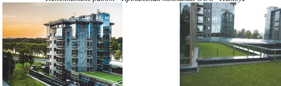
Жилой комплекс «ДИАДЕМА» 2011 г. Интенсивное озеленение кровли выполнено по технологии ZinCo. Рис. 1. Примеры озеленения кровель
