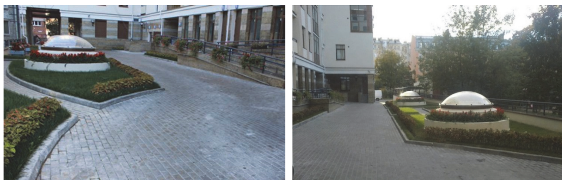
Жилой комплекс «Дом на ул. Детской» 2012 г. Интенсивное озеленение кровли выполнено по технологии Bauder. Исполнитель работ - Кровельная компания ООО "Нимбус"
