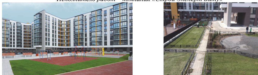
Жилой комплекс «СУОМИ» 2014-2015 г. Интенсивное озеленение кровли выполнено по технологии Bauder. Исполнитель работ - Кровельная компания ООО "Нимбус"
