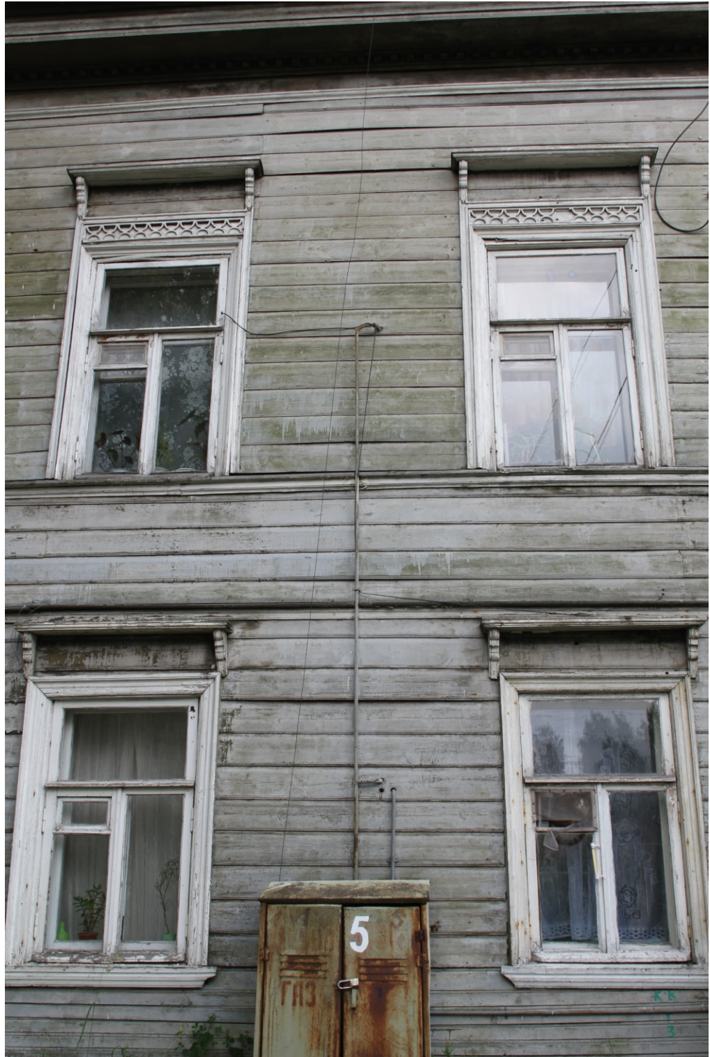
Ил. 12 «Жилой дом -со службами И.Т.Тимофеева, 2-ая пол. XIX в.: жилой дом; службы (беседка и ледник)», Ленинградская обл., Волховский район, г. Новая Ладога, Пионерская ул., д.18. Жилой дом. Фрагмент торцевого фасада. Фото: 15.08.2017.
