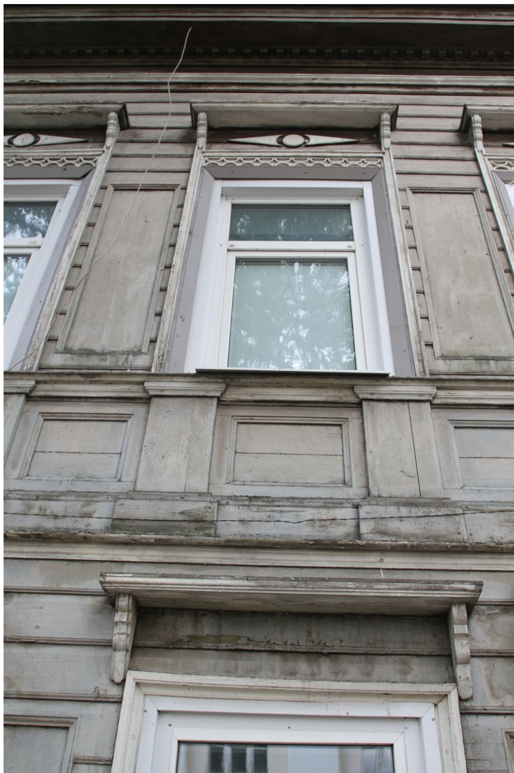
Ил. 13 «Жилой дом -со службами И.Т.Тимофеева, 2-ая пол. XIX в.: жилой дом; службы (беседка и ледник)», Ленинградская обл., Волховский район, г. Новая Ладога, Пионерская ул., д.18. Жилой дом. Фрагмент торцевого фасада. Фото: 15.08.2017.
