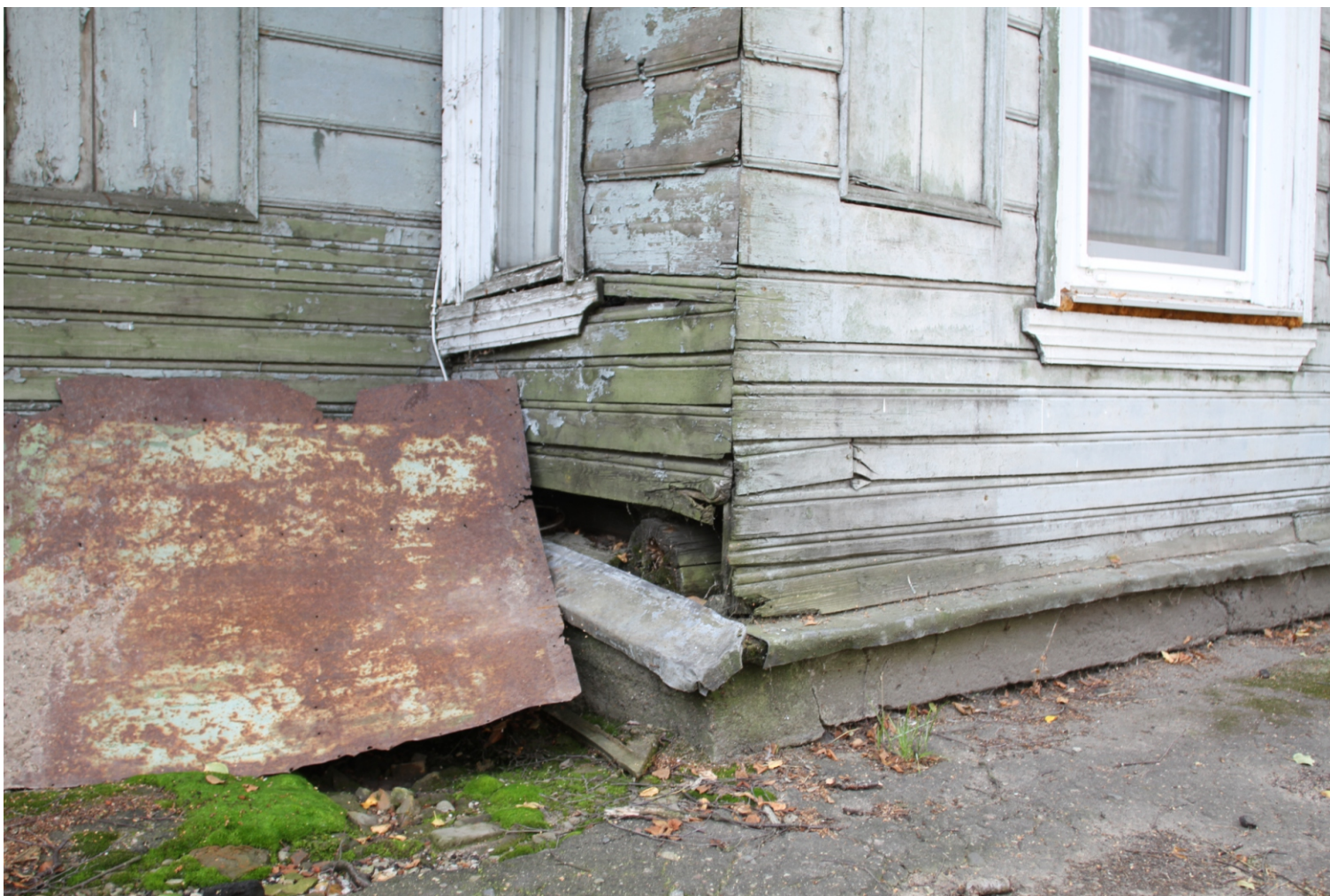
Ил. 9 «Жилой дом -со службами И.Т.Тимофеева, 2-ая пол. XIX в.: жилой дом; службы (беседка и ледник)», Ленинградская обл., Волховский район, г. Новая Ладога, Пионерская ул., д.18. Жилой дом. Лицевой фасад. Фрагмент. Фундамент. Фото: 15.08.2017.
