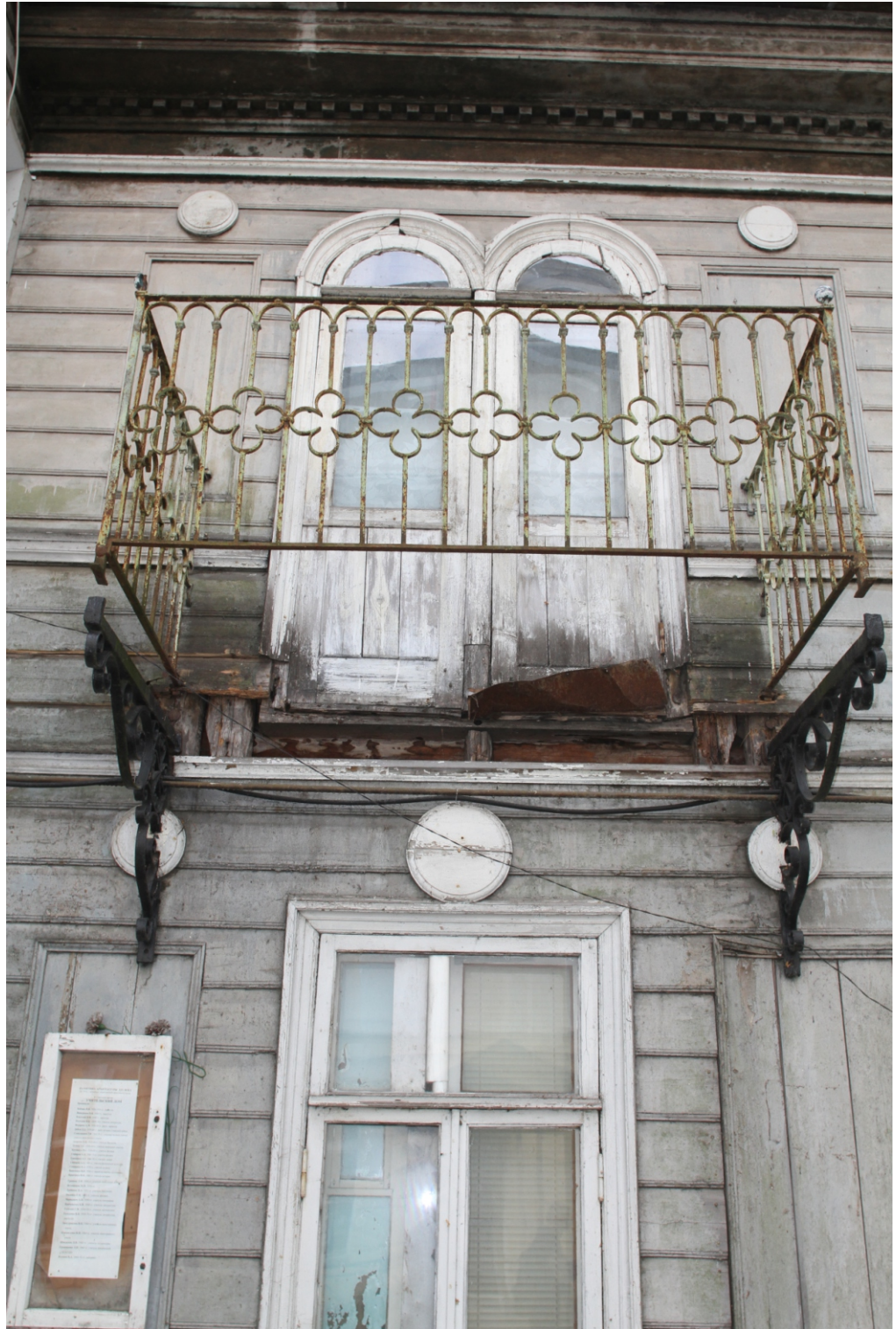
Ил. 7 «Жилой дом -со службами И.Т.Тимофеева, 2-ая пол. XIX в.: жилой дом; службы (беседка и ледник)», Ленинградская обл., Волховский район, г. Новая Ладога, Пионерская ул., д.18. Жилой дом. Фрагмент лицевого фасада. Балкон. Фото: 15.08.2017.
