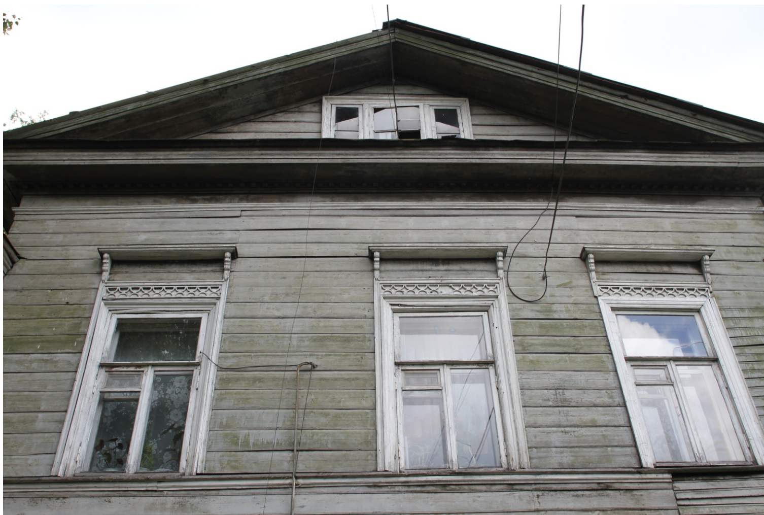
Ил. 14 «Жилой дом -со службами И.Т.Тимофеева, 2-ая пол. XIX в.: жилой дом; службы (беседка и ледник)», Ленинградская обл., Волховский район, г. Новая Ладога, Пионерская ул., д.18. Жилой дом. Фрагмент торцевого фасада. Верхний этаж с фронтоном. Фото: 15.08.2017.
