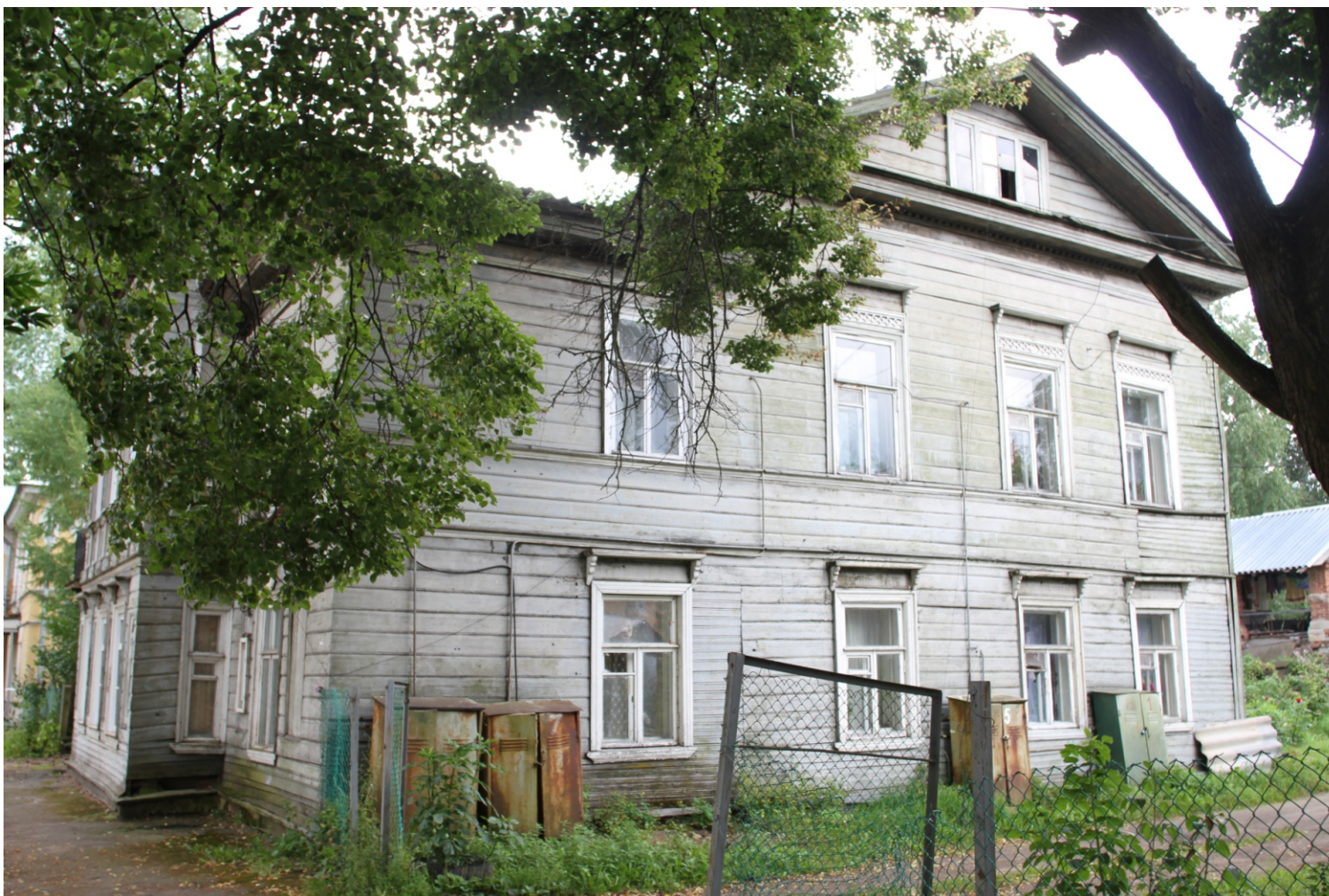
Ил. 10 «Жилой дом -со службами И.Т.Тимофеева, 2-ая пол. XIX в.: жилой дом; службы (беседка и ледник)», Ленинградская обл., Волховский район, г. Новая Ладога, Пионерская ул., д.18. Жилой дом. Торцевой фасад. Общий вид. Фото: 15.08.2017.
