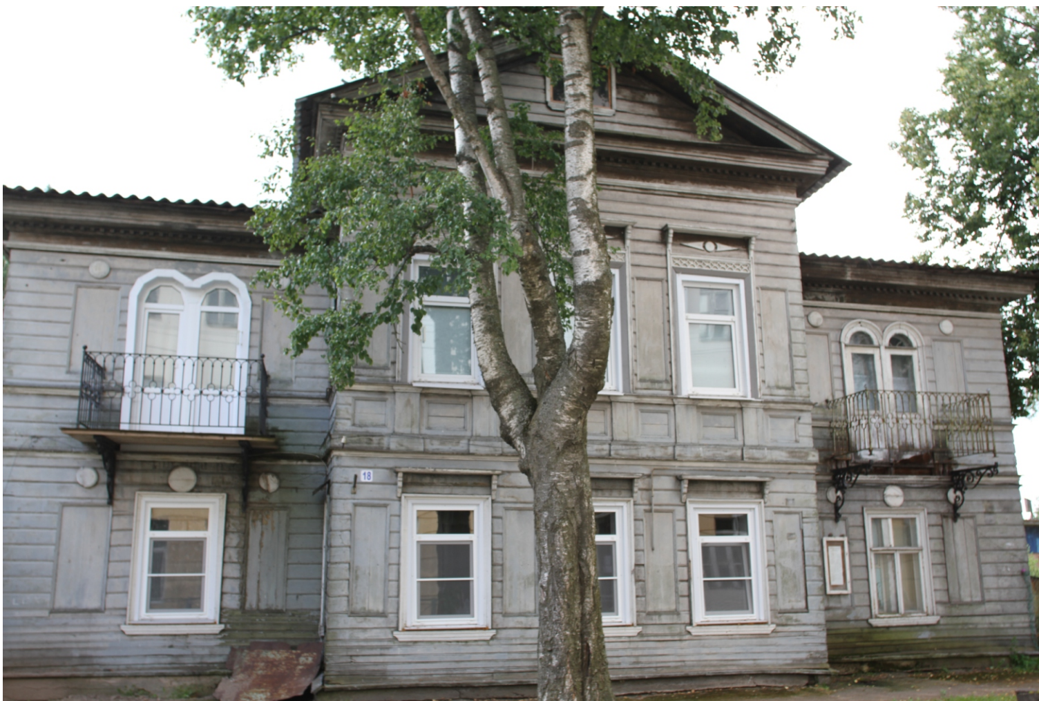
Ил. 2 «Жилой дом -со службами И.Т.Тимофеева, 2-ая пол. XIX в.: жилой дом; службы (беседка и ледник)», Ленинградская обл., Волховский район, г. Новая Ладога, Пионерская ул., д.18. Жилой дом. Лицевой фасад. Фото: 15.08.2017.
