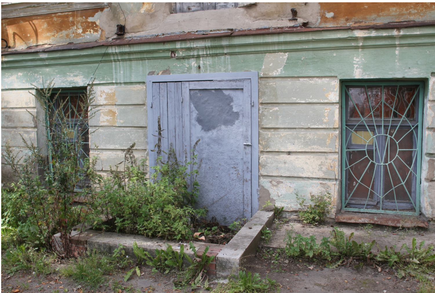
Ил. 14 «Жилой дом -бывший дом Г.Е.Ильинского, XVIII-XIX вв.», входящий в состав ансамбля «Комплекс жилых и хозяйственных зданий, XVIII-XIX вв.».
