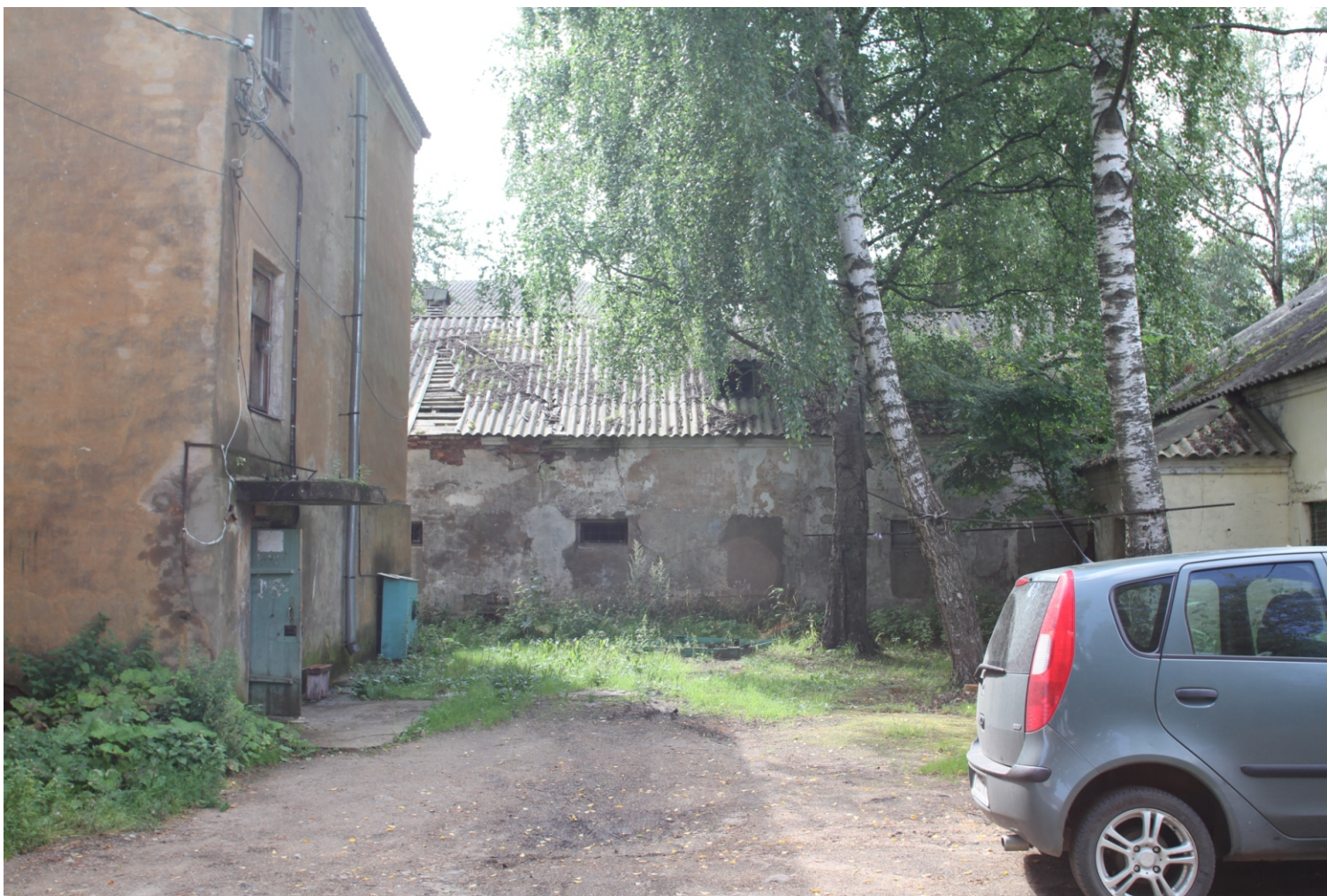
Ил. 17 «Жилой дом -бывший дом Г.Е.Ильинского, XVIII-XIX вв.», входящий в состав ансамбля «Комплекс жилых и хозяйственных зданий, XVIII-XIX вв.». Ленинградская обл., Волховский район, г. Новая Ладога, наб. Ладожской Флотилии, д.22. Хозяйственное здание. Фрагмент северного фасада. Фото: 15.08.2017.
