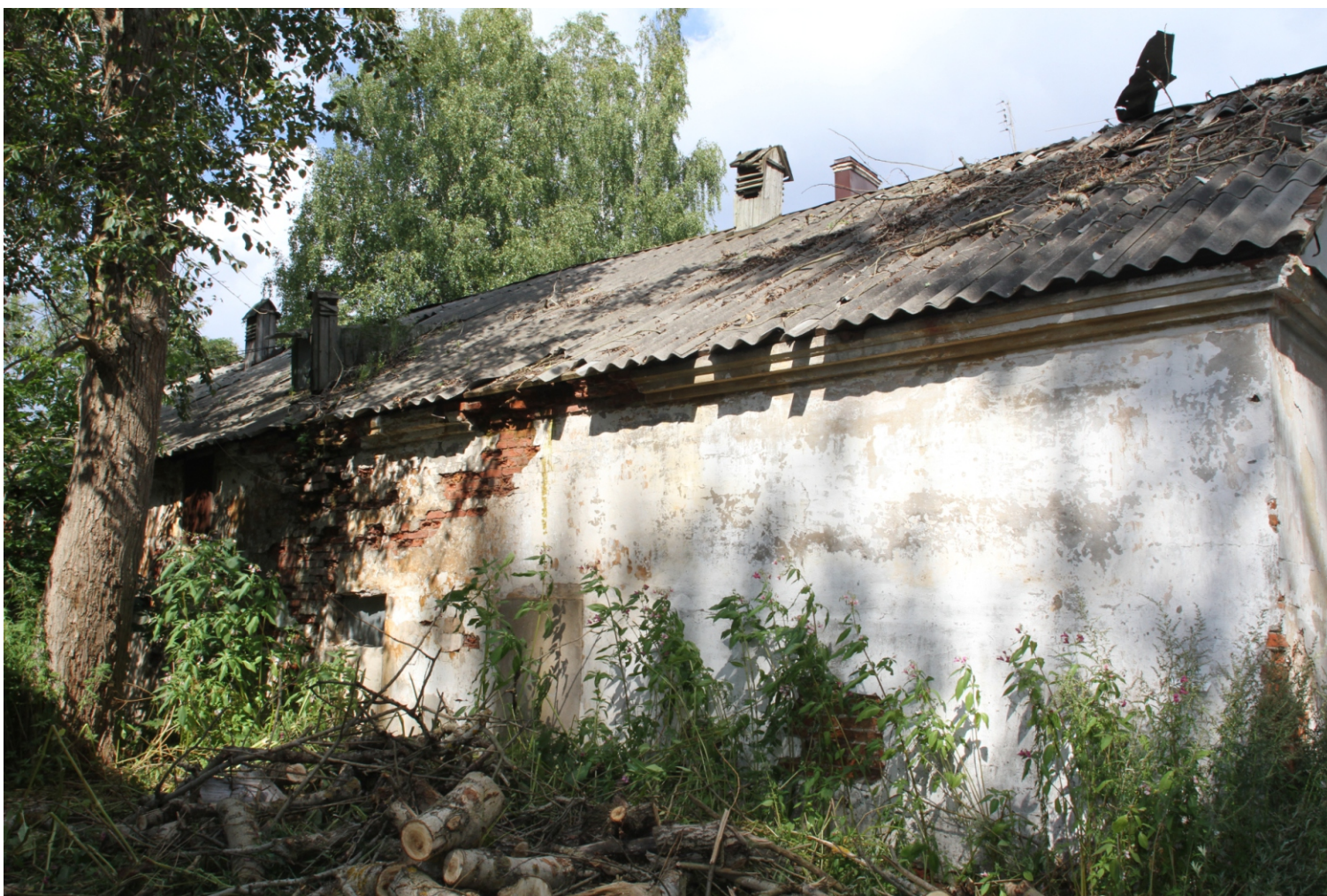
Ил. 18 «Жилой дом -бывший дом Г.Е.Ильинского, XVIII-XIX вв.», входящий в состав ансамбля «Комплекс жилых и хозяйственных зданий, XVIII-XIX вв.». Ленинградская обл., Волховский район, г. Новая Ладога, наб. Ладожской Флотилии, д.22. Хозяйственное здание. Фрагмент южного фасада. Фото: 15.08.2017.
