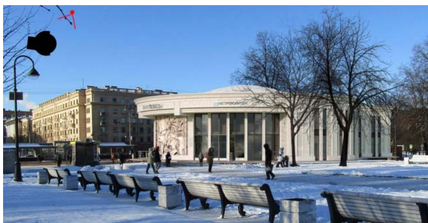
Вариант 5. Неоклассицизм. Вид с улицы Басейная. Реконструкции наземного вестибюля станции метрополитена «Парк Победы»
