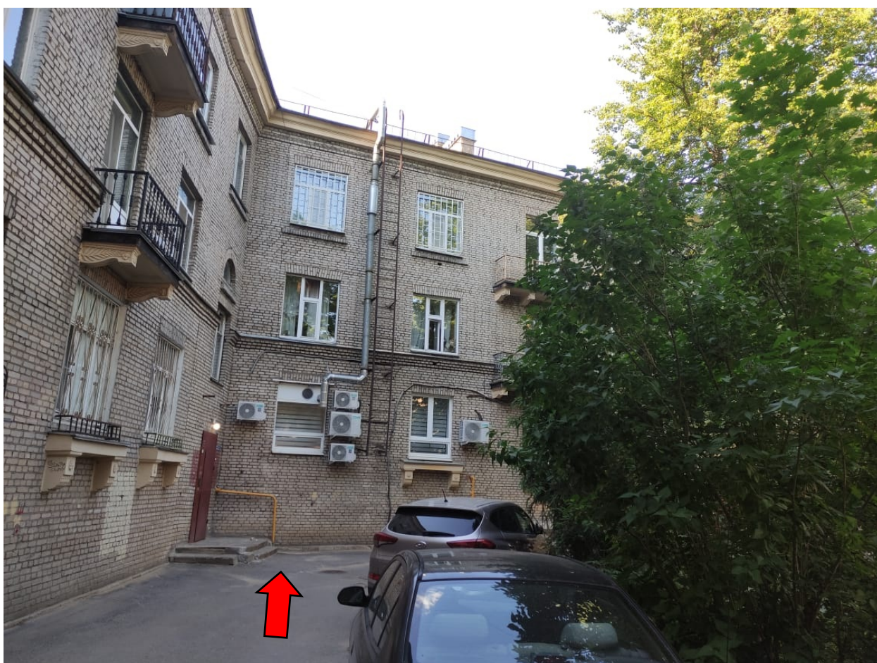
Рис. 1. Вид на Объект (место будущей двери отмечено стрелкой) с дворовой территории. Фото от 01.07.2021 г.
