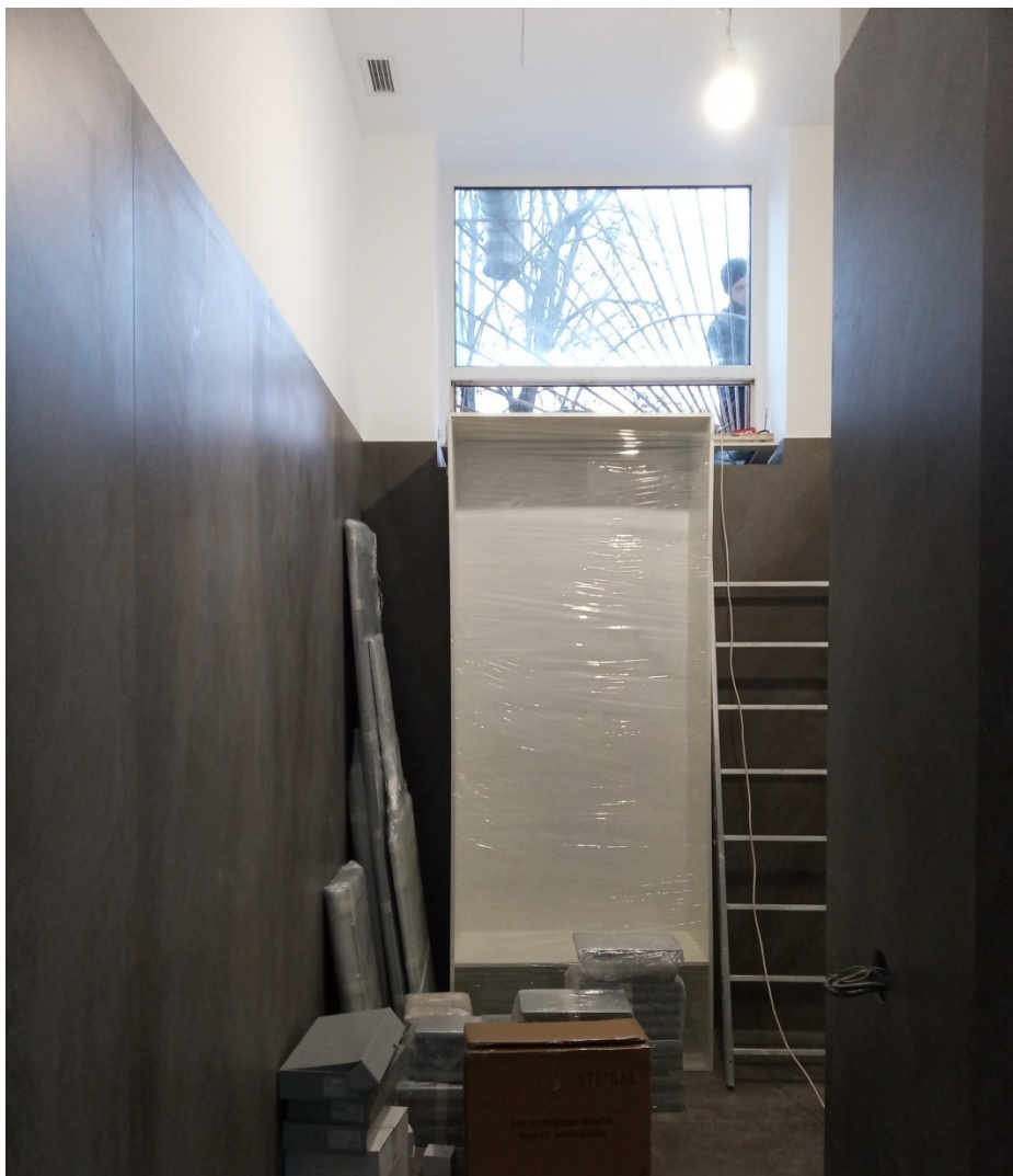
Рис. 3. Вид на Объект – место будущей двери изнутри помещения 1-Н.
