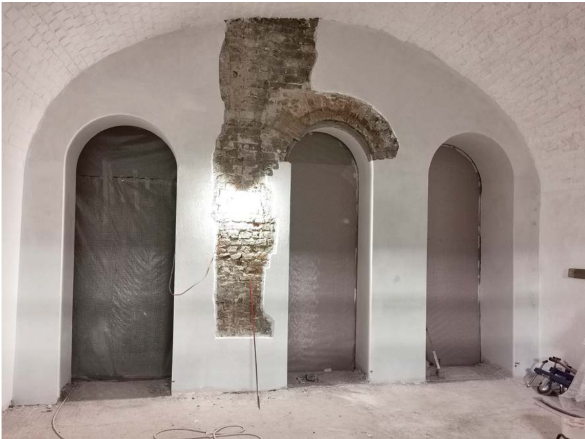
Фото 42. Строение 1. Центральная часть. Помещение левого крыла 1-го этажа. Фрагмент интерьера. Март 2022 г.
