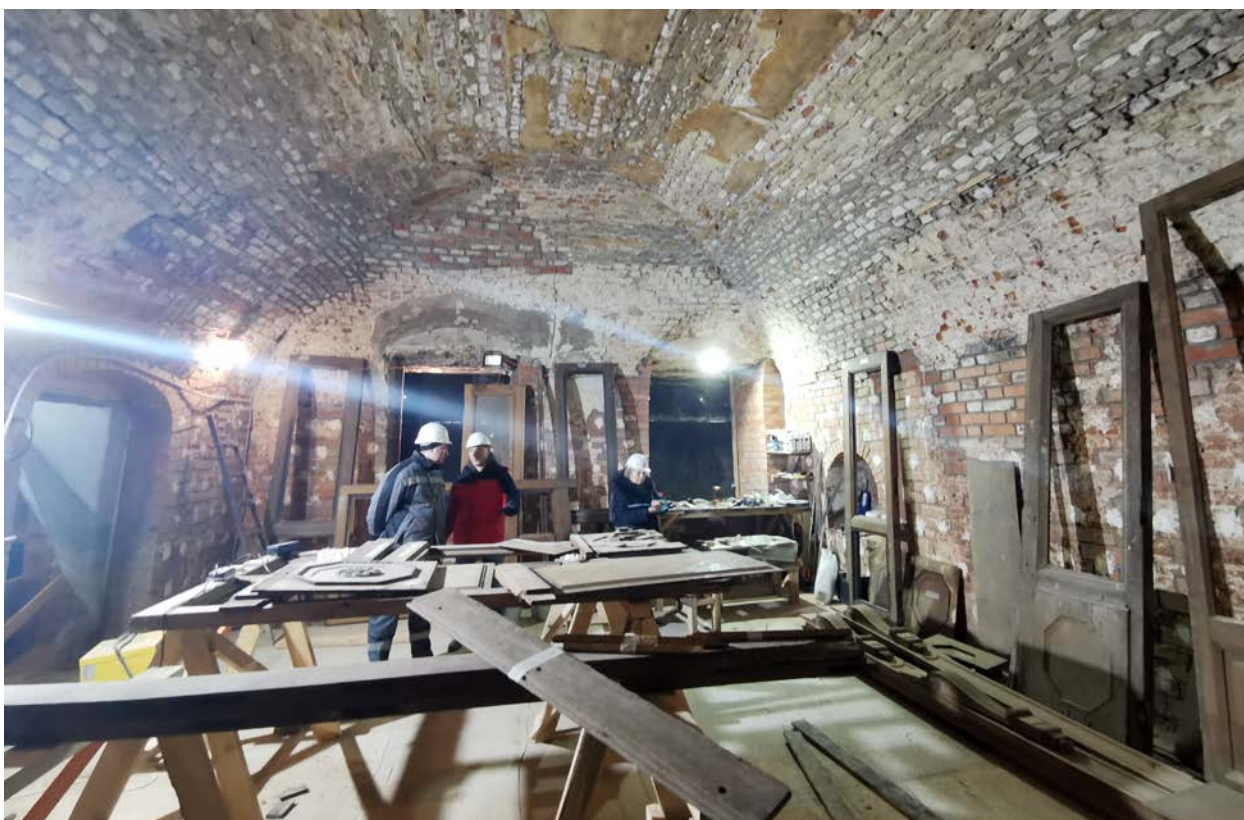
Фото 17. Строение 1. Центральная часть. Помещение левого крыла 1-го этажа. Фрагмент интерьера. Март 2022 г.
