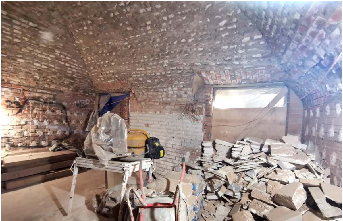
Фото 26. Строение 1. Центральная часть. Помещение правого крыла 1-го этажа. Фрагмент интерьера. Март 2022 г.
