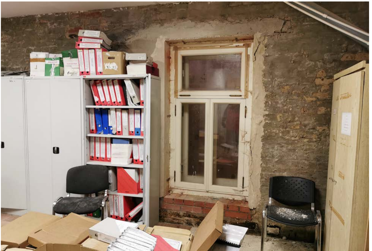
Фото 10. Строение 2. Подвал. Фрагмент интерьера. Март 2022 г.
