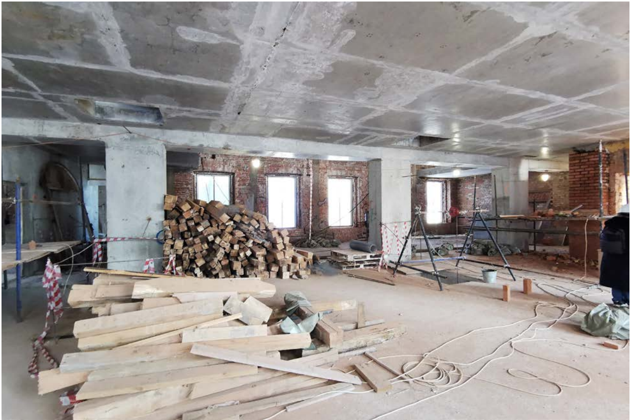
Фото 69. Строеение 1. Левая пристройка. Помещение 2-го этажа. Фрагмент интерьера. Март 2022 г.
