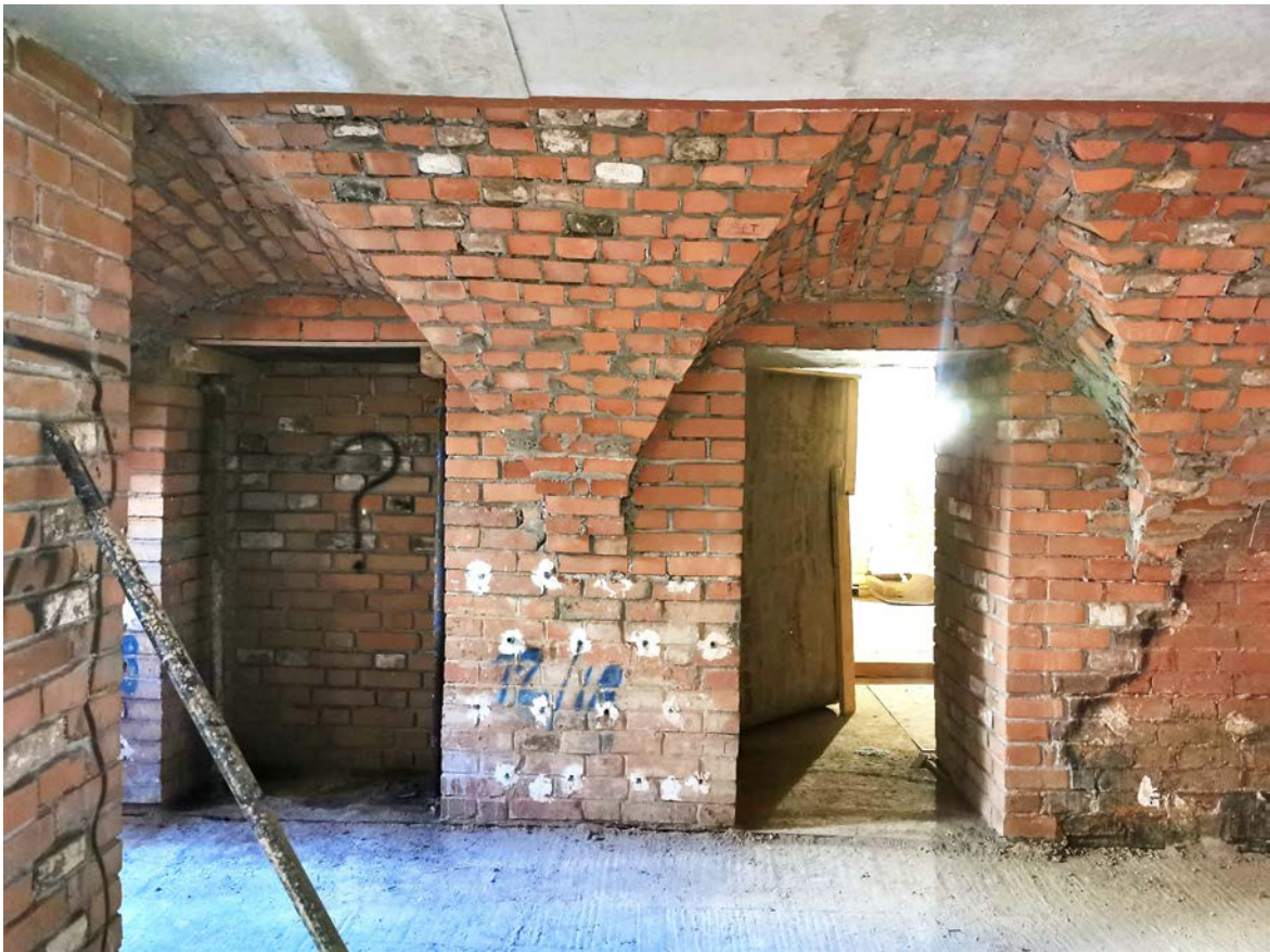
Фото 33. Строение 1. Центральная часть. Помещение правого крыла 1-го этажа. Фрагмент интерьера. Март 2022 г.
