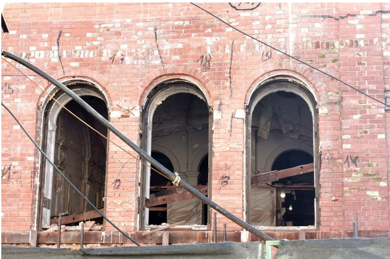
Фото 7. Строение 1. Фрагмент фасада центральной части. Вид со стороны Большого Знаменского пер. Март 2022 г.
