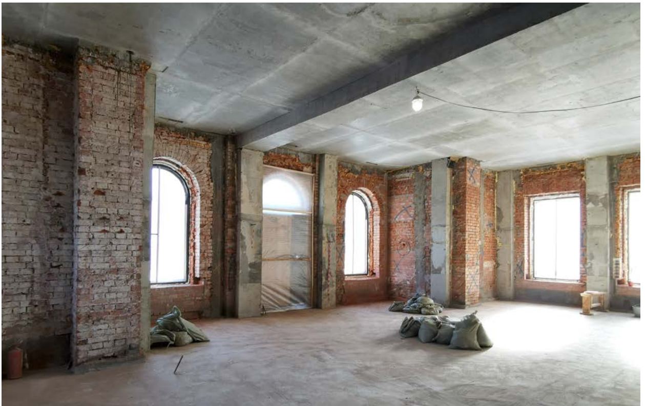
Фото 79. Строение 1. Левая пристройка. Помещение 1-го этажа. Фрагмент интерьера. Март 2022 г.
