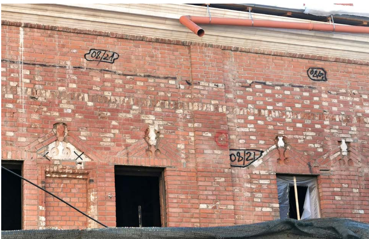
Фото 8. Строение 1. Фрагмент фасада центральной части. Вид со стороны Большого Знаменского пер. Март 2022 г.
