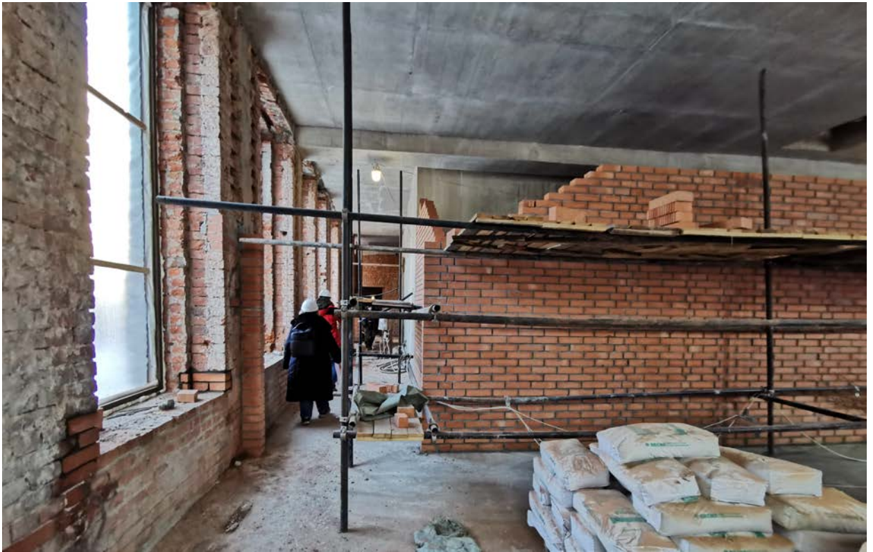
Фото 84. Строение 1. Левая пристройка. Помещение 1-го этажа. Фрагмент интерьера. Март 2022 г.
