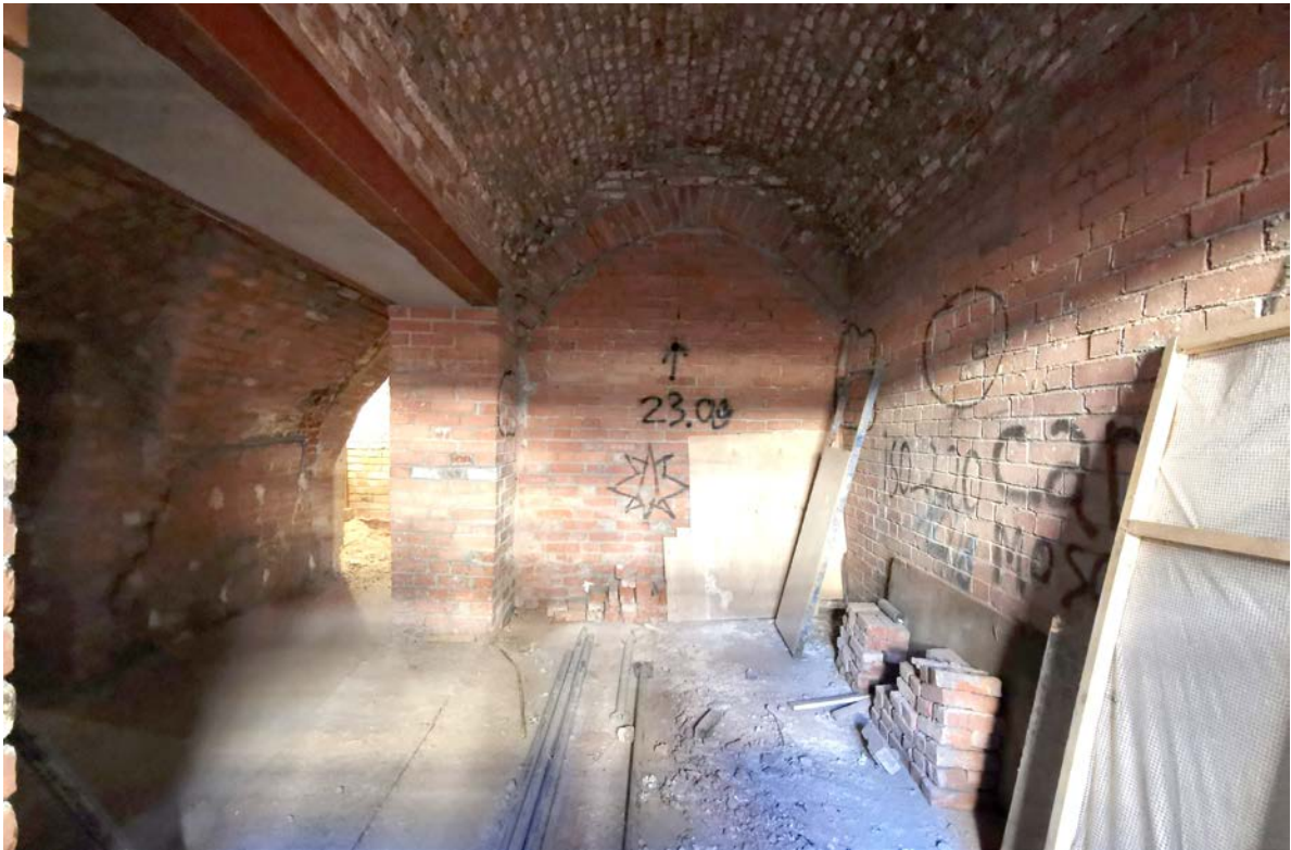
Фото 31. Строение 1. Центральная часть. Помещение правого крыла 1-го этажа. Фрагмент интерьера. Март 2022 г.
