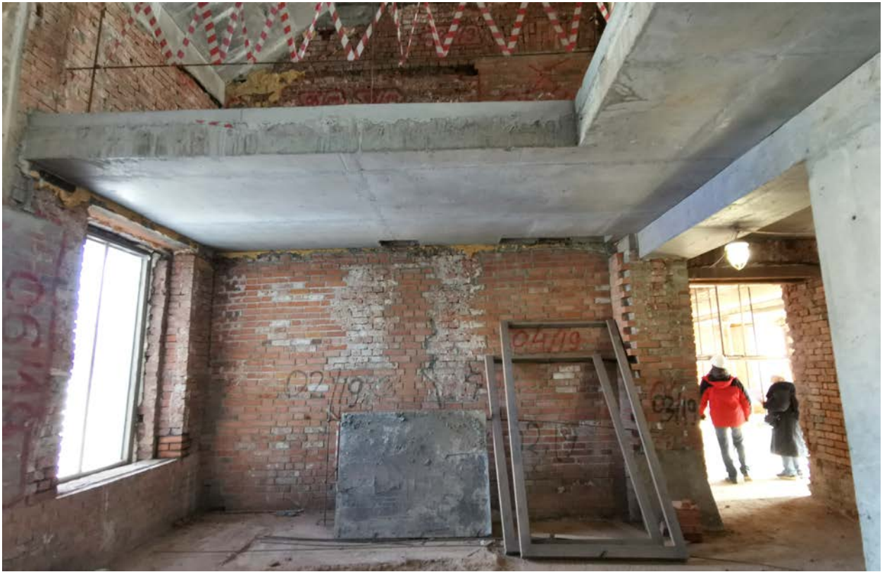
Фото 71. Строение 1. Левая пристройка. Помещение 2-го этажа. Фрагмент интерьера. Март 2022 г.
