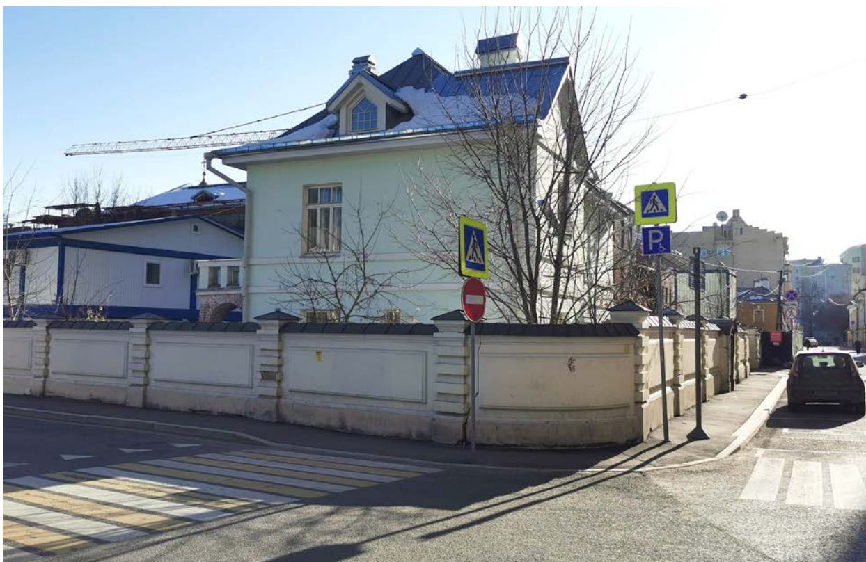
Фото 4. Пересечение Колымажного и Б. Знаменского переулков. Ограда усадьбы. Февраль 2022 г.
