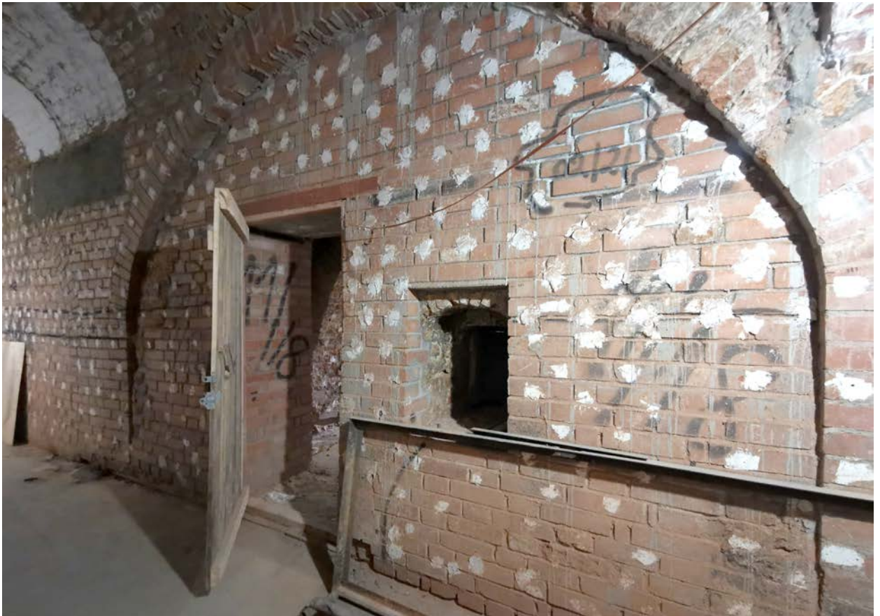
Фото 40. Строение 1. Центральная часть. Помещение левого крыла 1-го этажа. Фрагмент интерьера. Март 2022 г.
