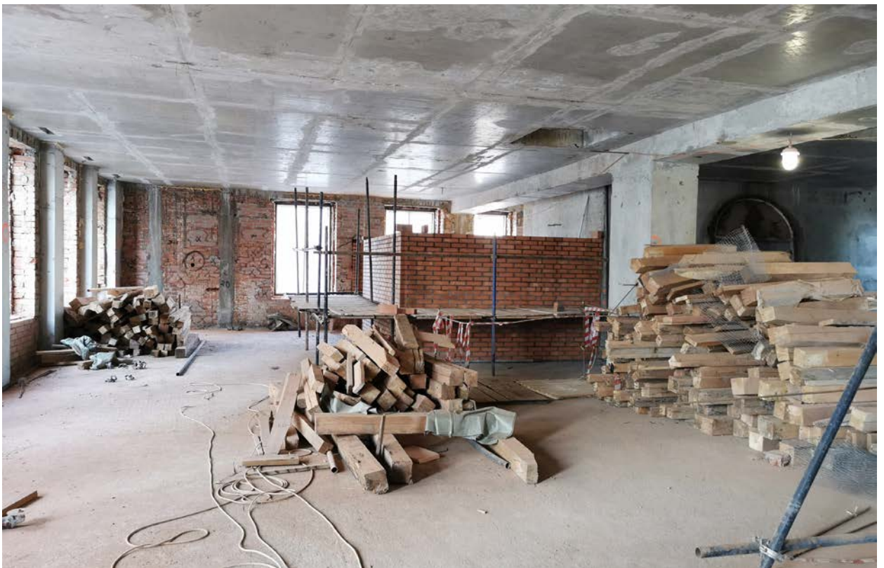
Фото 70. Строеение 1. Левая пристройка. Помещение 2-го этажа. Фрагмент интерьера. Март 2022 г.
