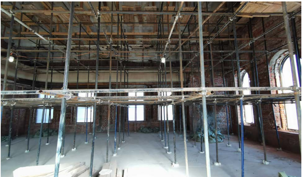
Фото 72. Строение 1. Левая пристройка. Двухсветный зал 2-го этажа. Фрагмент интерьера. Март 2022 г.
