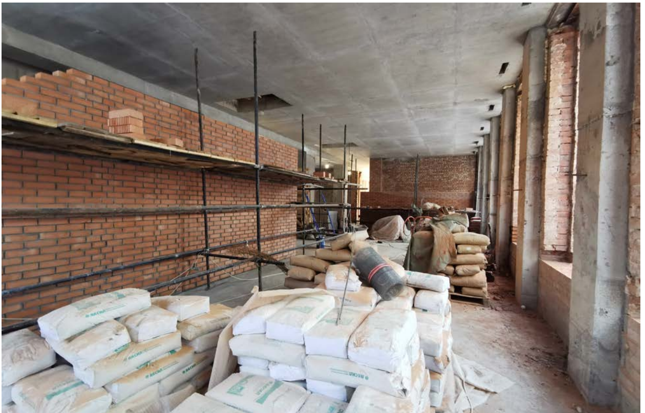
Фото 83. Строение 1. Левая пристройка. Помещение 1-го этажа. Фрагмент интерьера. Март 2022 г.
