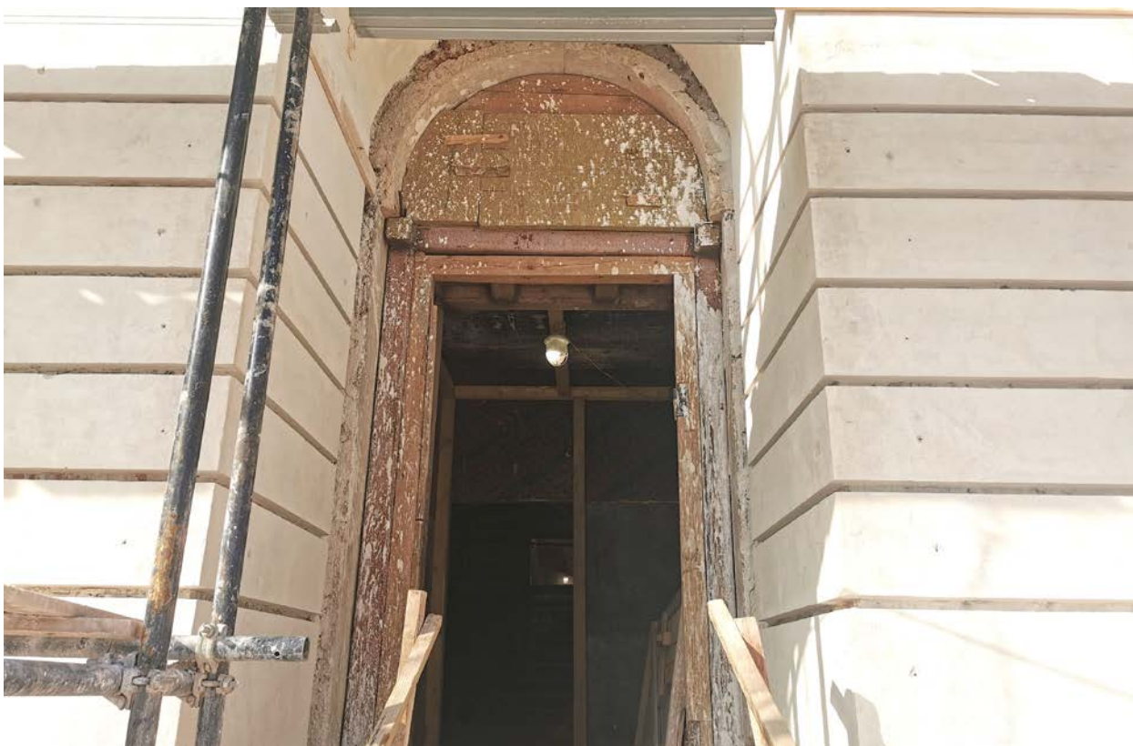
Фото 11. Строение 1. Фрагмент фасада центральной части. Вид со стороны парадного двора. Март 2022 г.
