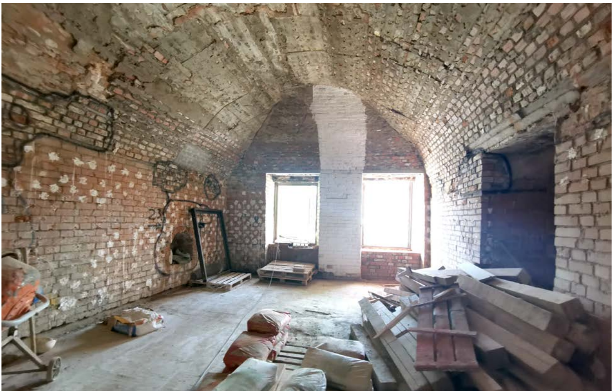
Фото 20. Строение 1. Центральная часть. Помещение правого крыла 1-го этажа. Фрагмент интерьера. Март 2022 г.
