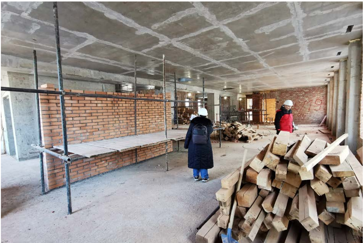
Фото 68. Строение 1. Левая пристройка. Помещение 2-го этажа. Фрагмент интерьера. Март 2022 г.
