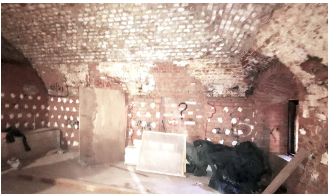
Фото 30. Строение 1. Центральная часть. Помещение правого крыла 1-го этажа. Фрагмент интерьера. Март 2022 г.
