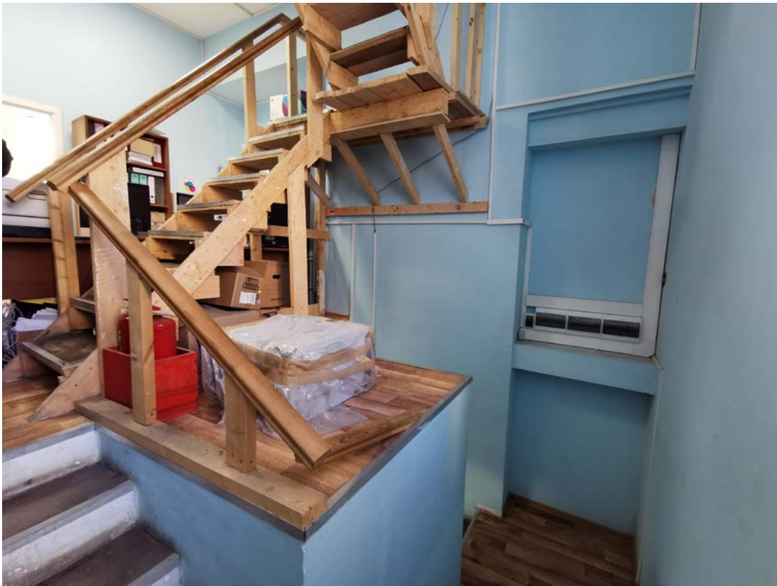
Фото 16. Строение 2. Лестничная площадка между 1 и 2-м этажами. Фрагмент интерьера. Март 2022 г.
