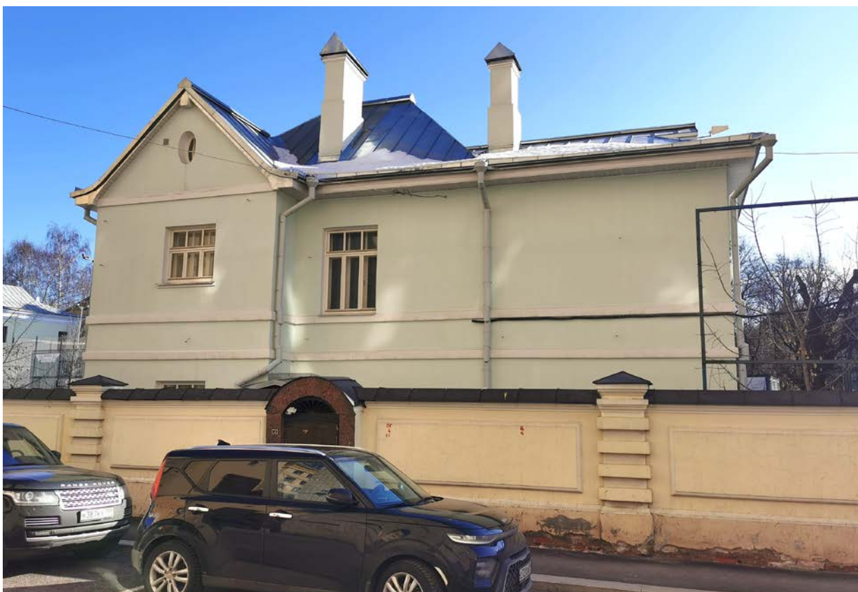
Фото 3. Строеение 2. Общий вид с запада от Большого Знаменского пер. Март 2022г.
