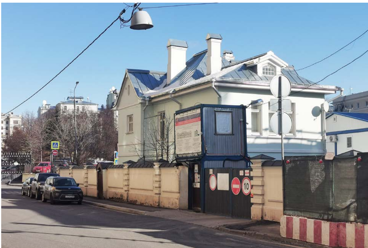
Фото 4. Строеение 2. Общий вид с юго-запада от Большого Знаменского пер. Март 2022 г.
