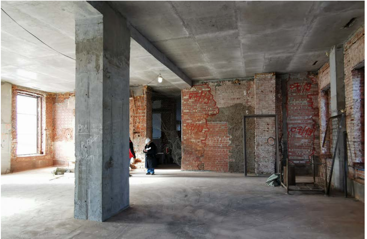
Фото 81. Строение 1. Левая пристройка. Помещение 1-го этажа. Фрагмент интерьера. Март 2022 г.
