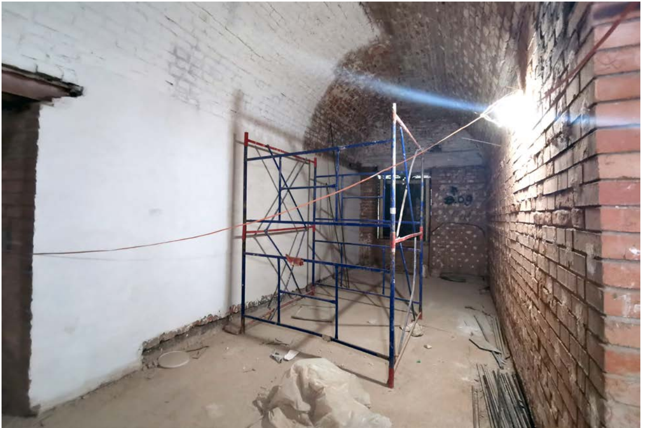
Фото 21. Строение 1. Центральная часть. Помещение правого крыла 1-го этажа. Фрагмент интерьера. Март 2022 г.
