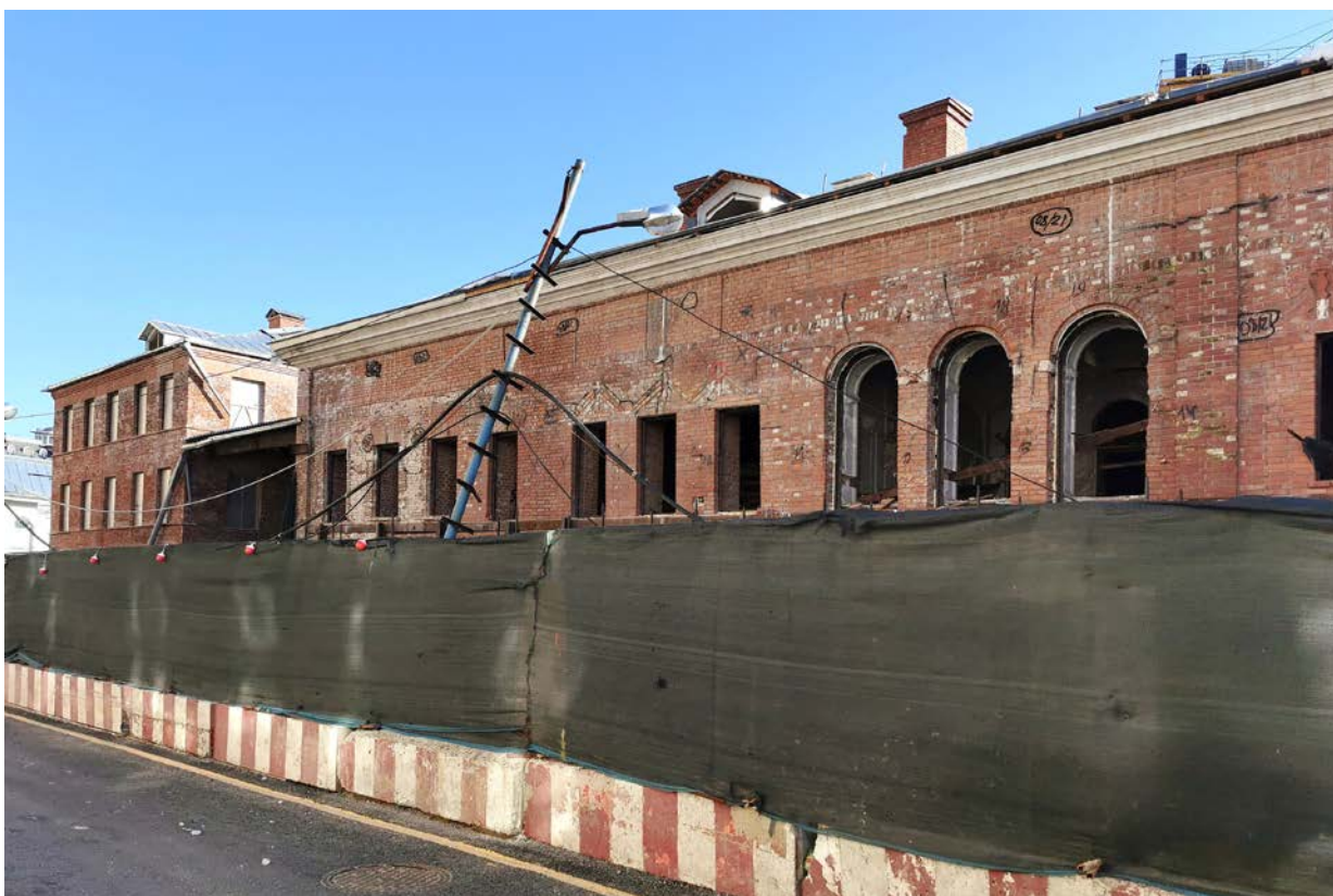
Фото 5. Строение 1. Общий вид со стороны Большого Знаменского пер. Март 2022 г.
