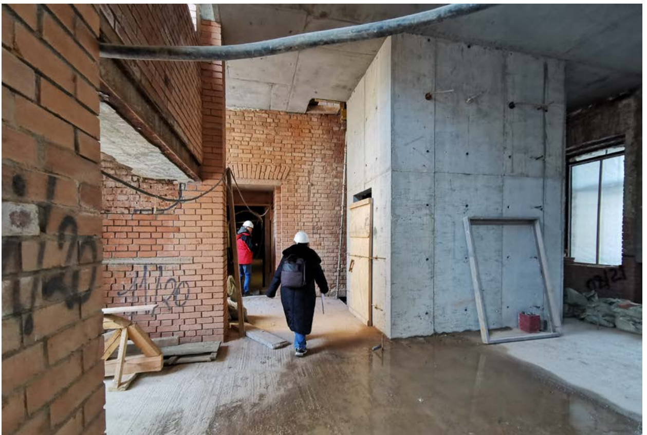
Фото 85. Строение 1. Левая пристройка. Помещение 1-го этажа. Фрагмент интерьера. Март 2022 г.
