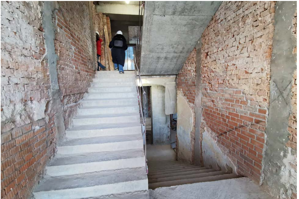
Фото 90. Строение 1. Правая пристройка. Лестничный блок. Фрагмент интерьера. Март 2022 г.
