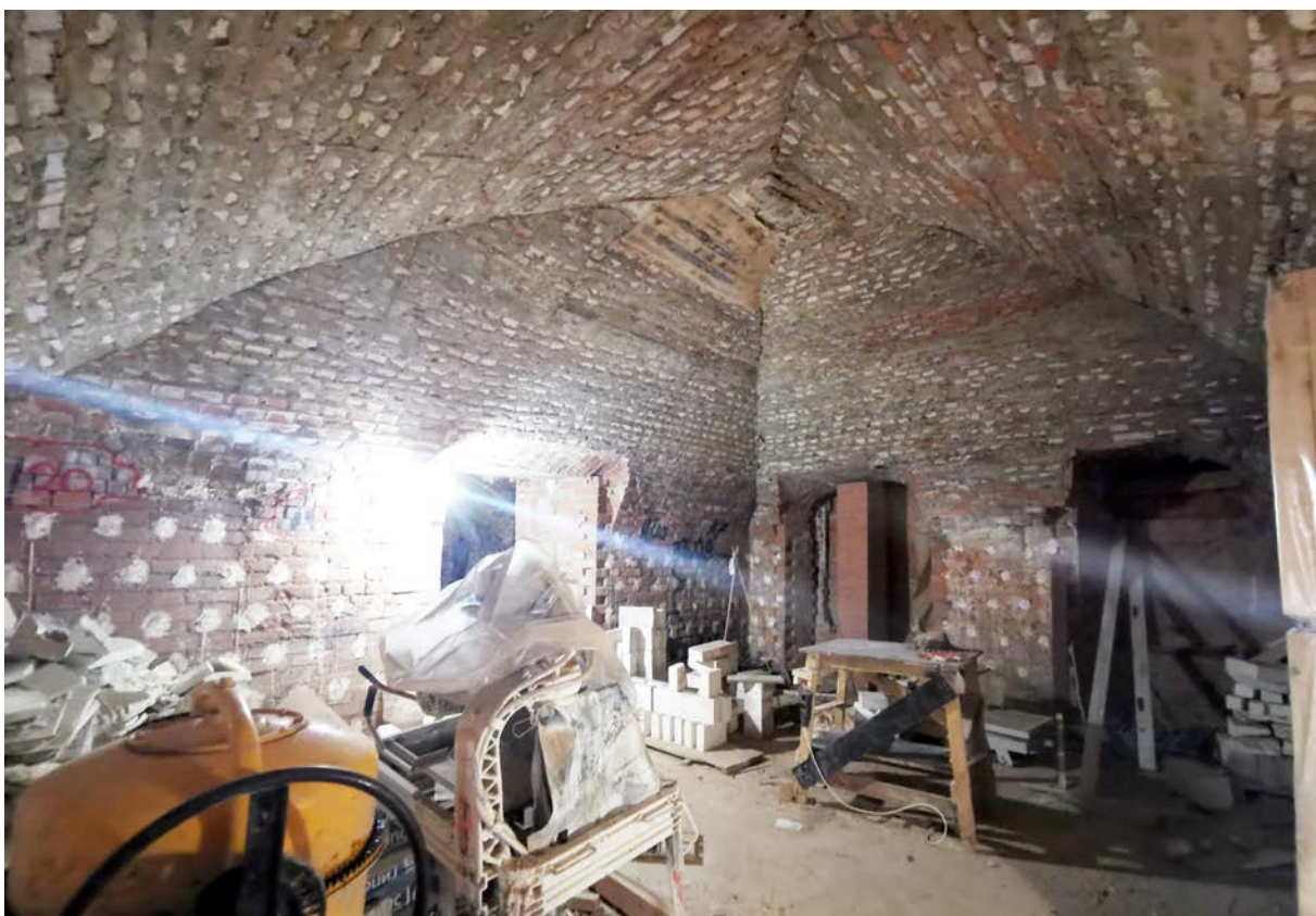
Фото 24. Строение 1. Центральная часть. Помещение правого крыла 1-го этажа. Фрагмент интерьера. Март 2022 г.
