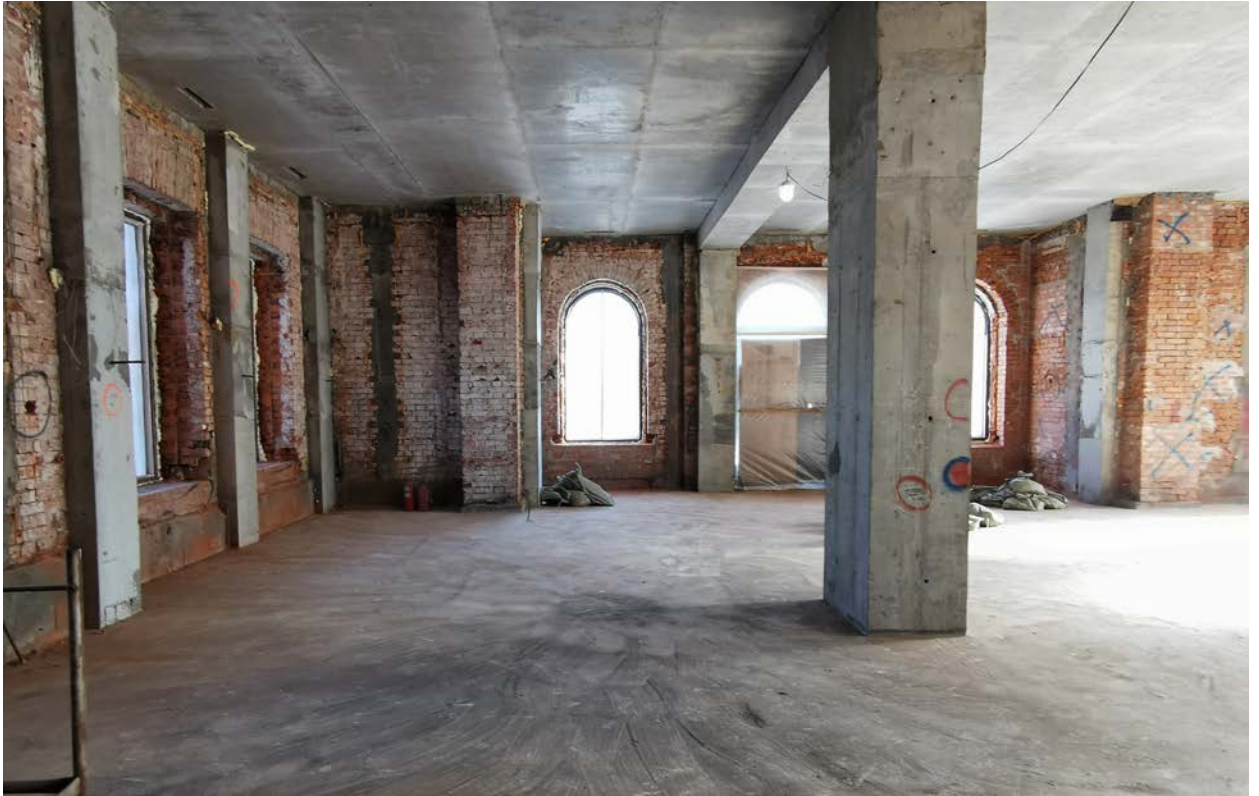
Фото 78. Строение 1. Левая пристройка. Помещение 1-го этажа. Фрагмент интерьера. Март 2022 г.
