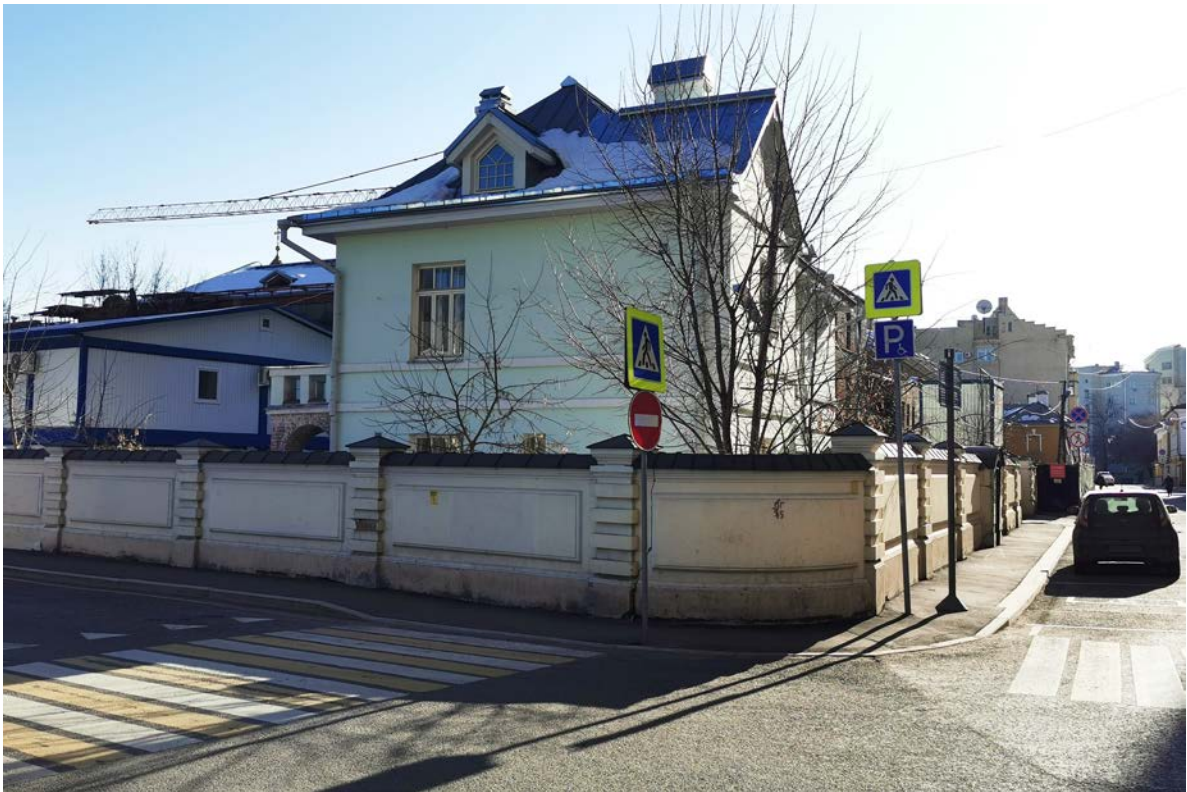
Фото 1. Строение 2. Общий вид от пересечения Большого Знаменского и Колымажного переулков. Март 2022 г.
