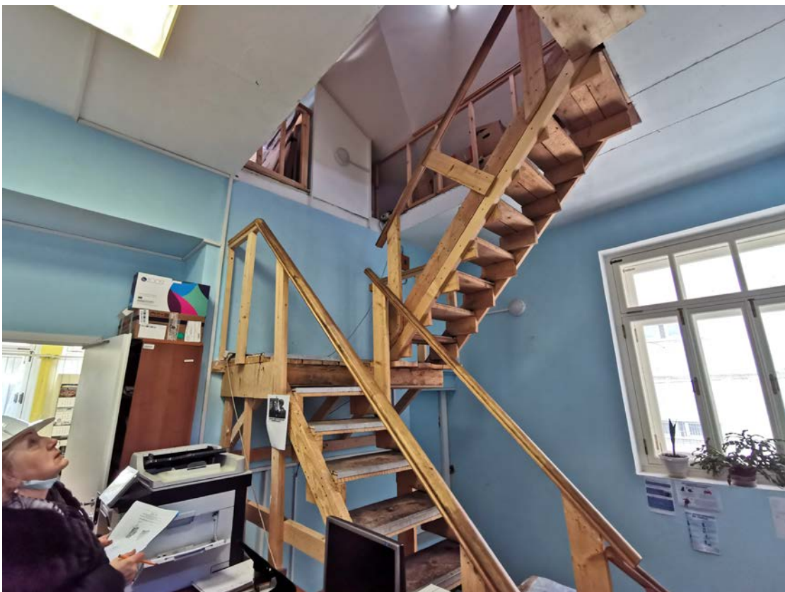
Фото 17. Строение 2. Помещение 2-го этажа. Лестница. Фрагмент интерьера. Март 2022 г.
