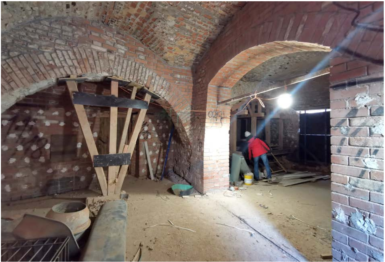
Фото 44. Строение 1. Центральная часть. Помещение левого крыла 1-го этажа. Фрагмент интерьера. Март 2022 г.
