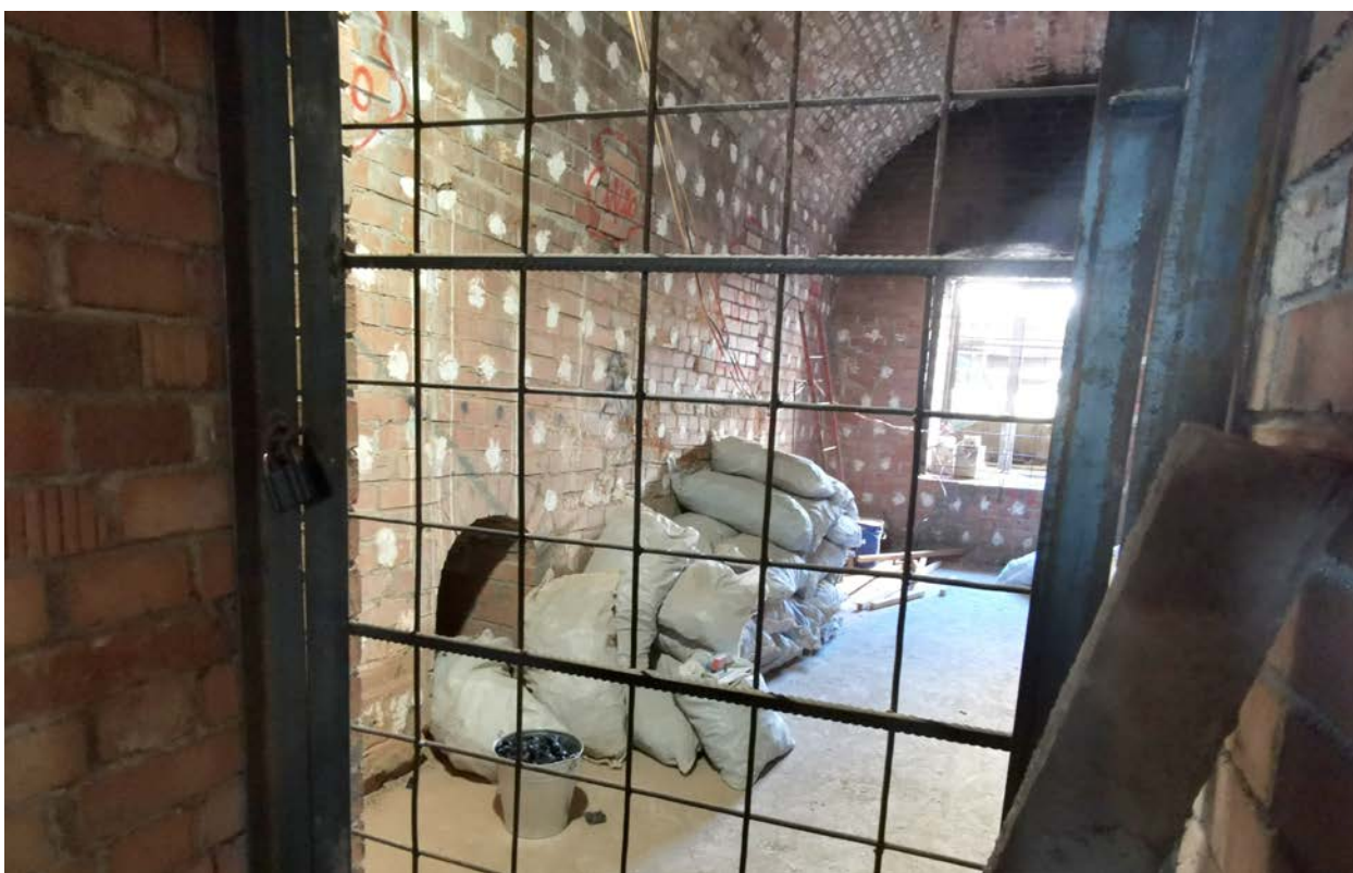
Фото 37. Строение 1. Центральная часть. Помещение правого крыла 1-го этажа. Фрагмент интерьера. Март 2022 г.
