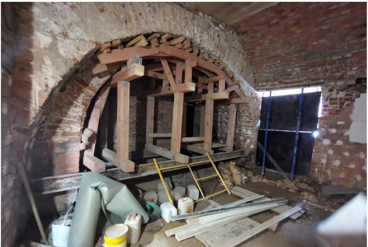
Фото 45. Строение 1. Центральная часть. Помещение левого крыла 1-го этажа. Фрагмент интерьера. Март 2022 г.
