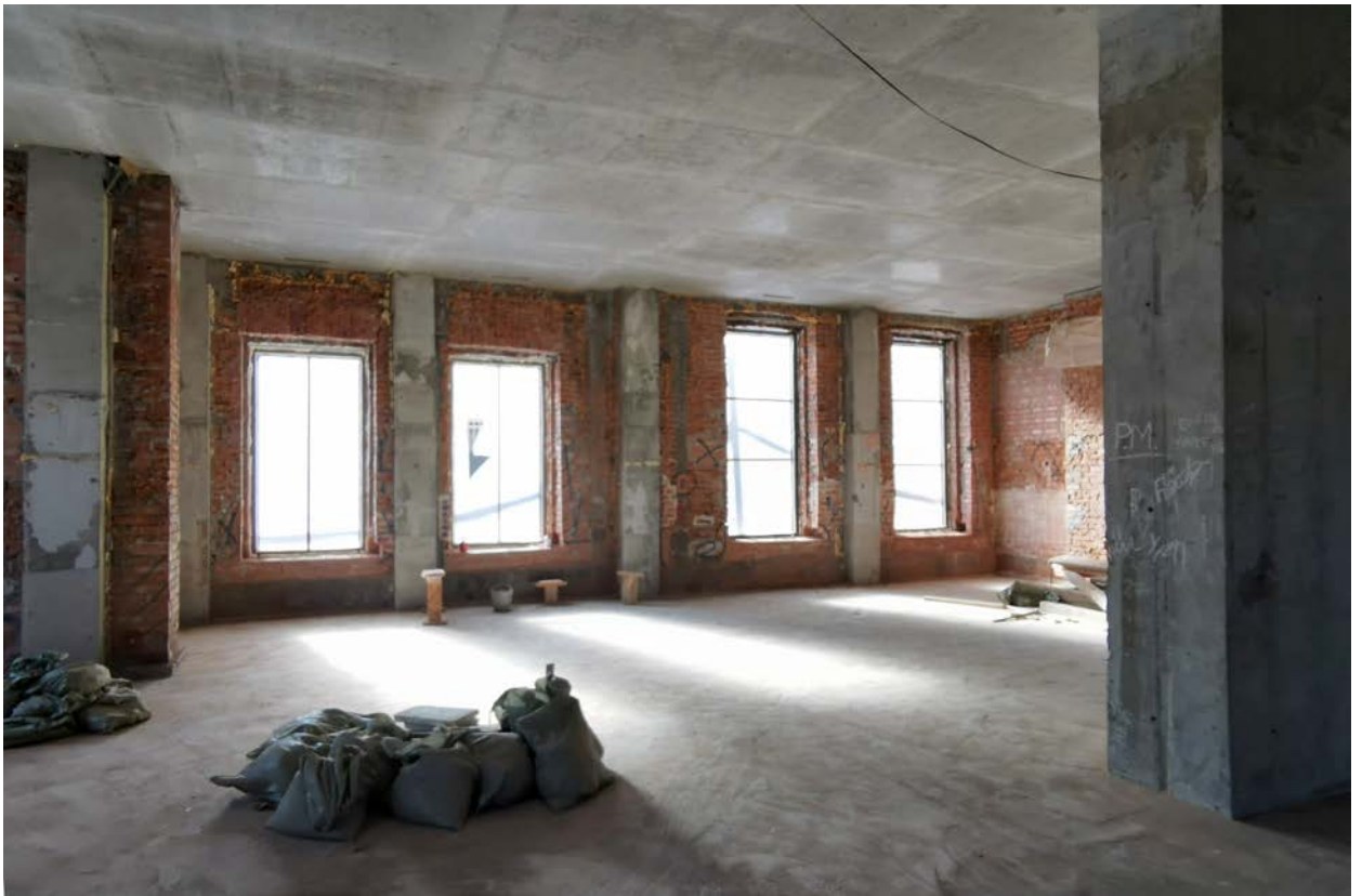
Фото 80. Строение 1. Левая пристройка. Помещение 1-го этажа. Фрагмент интерьера. Март 2022 г.
