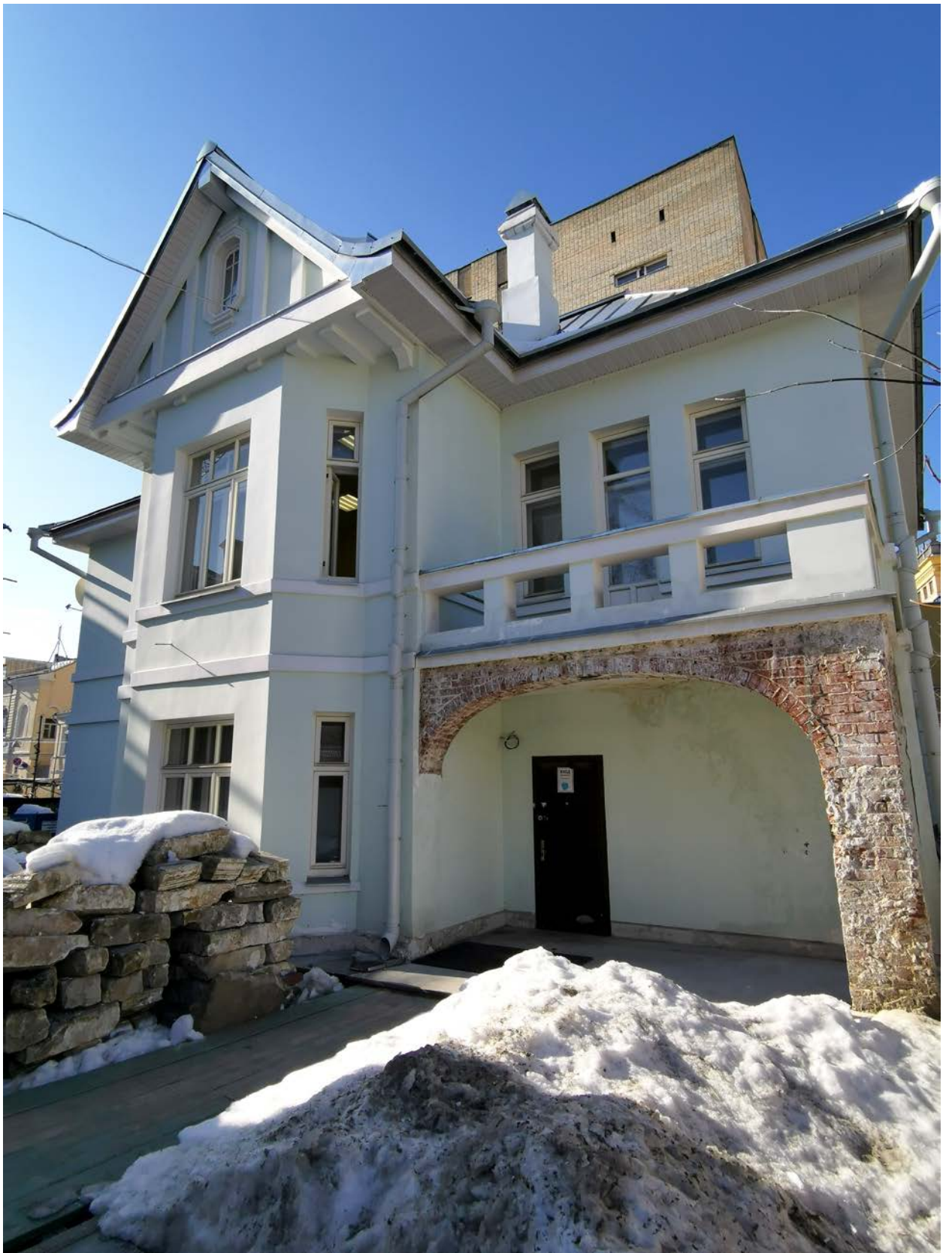
Фото 7. Строение 2. Общий вид главного фасада с востока. Март 2022 г.
