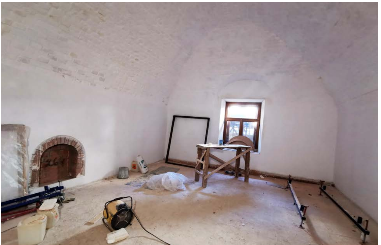
Фото 41. Строение 1. Центральная часть. Помещение левого крыла 1-го этажа. Фрагмент интерьера. Март 2022 г.
