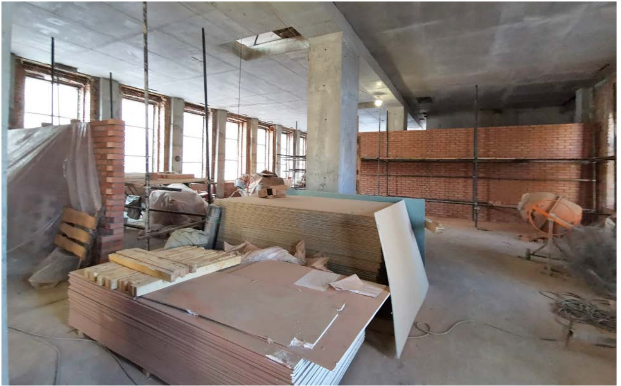
Фото 82. Строение 1. Левая пристройка. Помещение 1-го этажа. Фрагмент интерьера. Март 2022 г.
