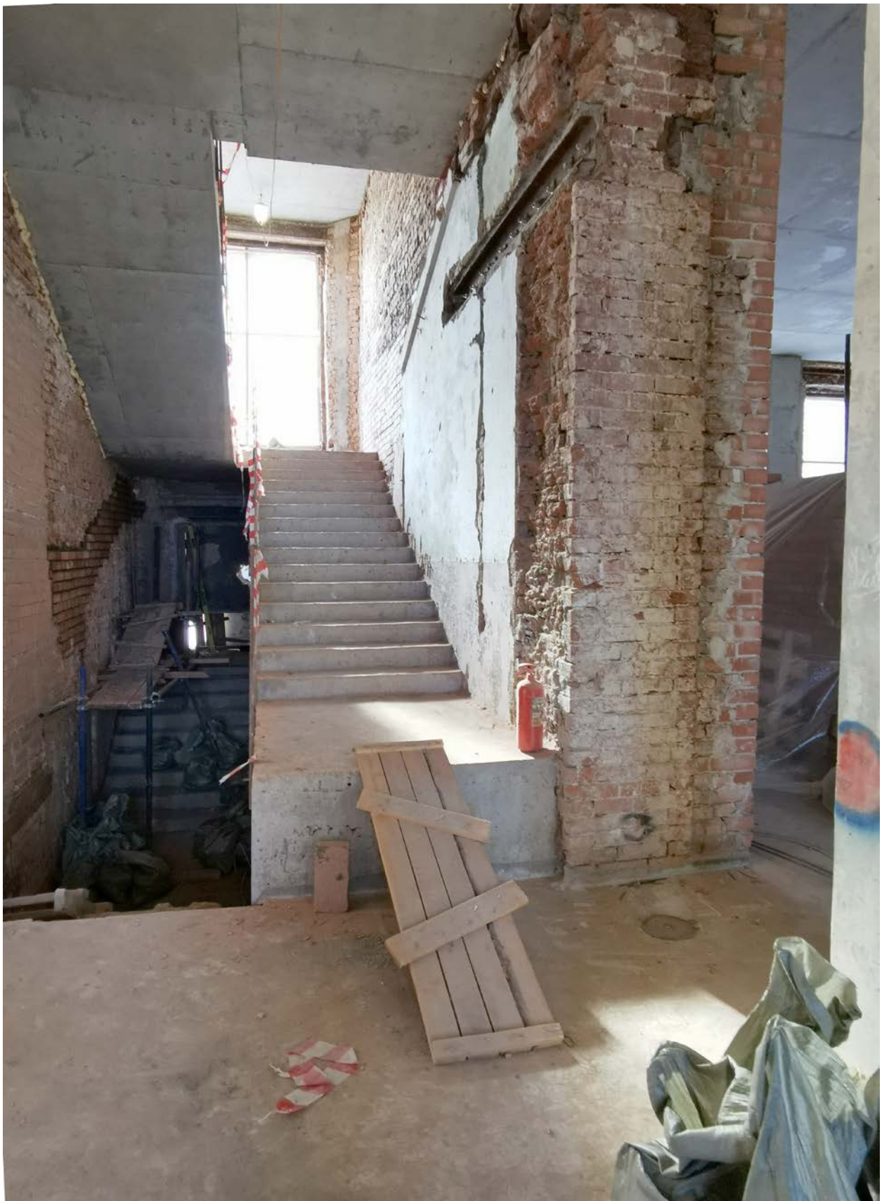
Фото 77. Строение 1. Левая пристройка. Лестничный блок 1-го этажа. Фрагмент интерьера. Март 2022 г.
